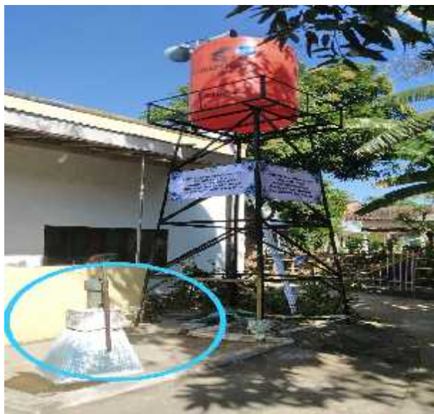
Gambar 2. Pembangunan Tandon di Sebelah Sumur yang Menggunakan Pompa Manual
