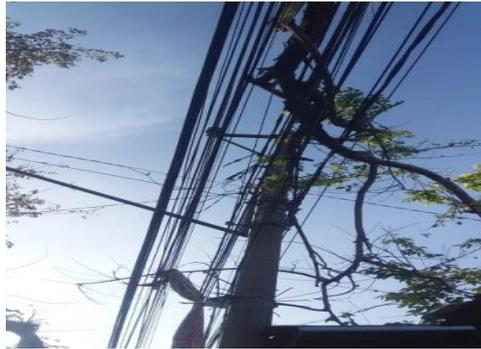
Gambar 12. Tipe kerusakan cabang patah/ mati
